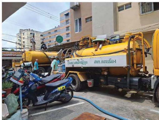
การสูบน้ำทิ้งจากระบบบำบัดน้ำเสีย
