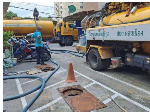
การสูบน้ำทิ้งจากระบบบำบัดน้ำเสีย
